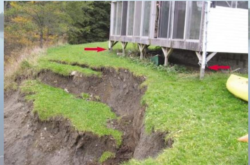
Gouttières (flèches) non raccordées à un tuyau allant jusqu'à la base du talus ou à un égout pluvial
